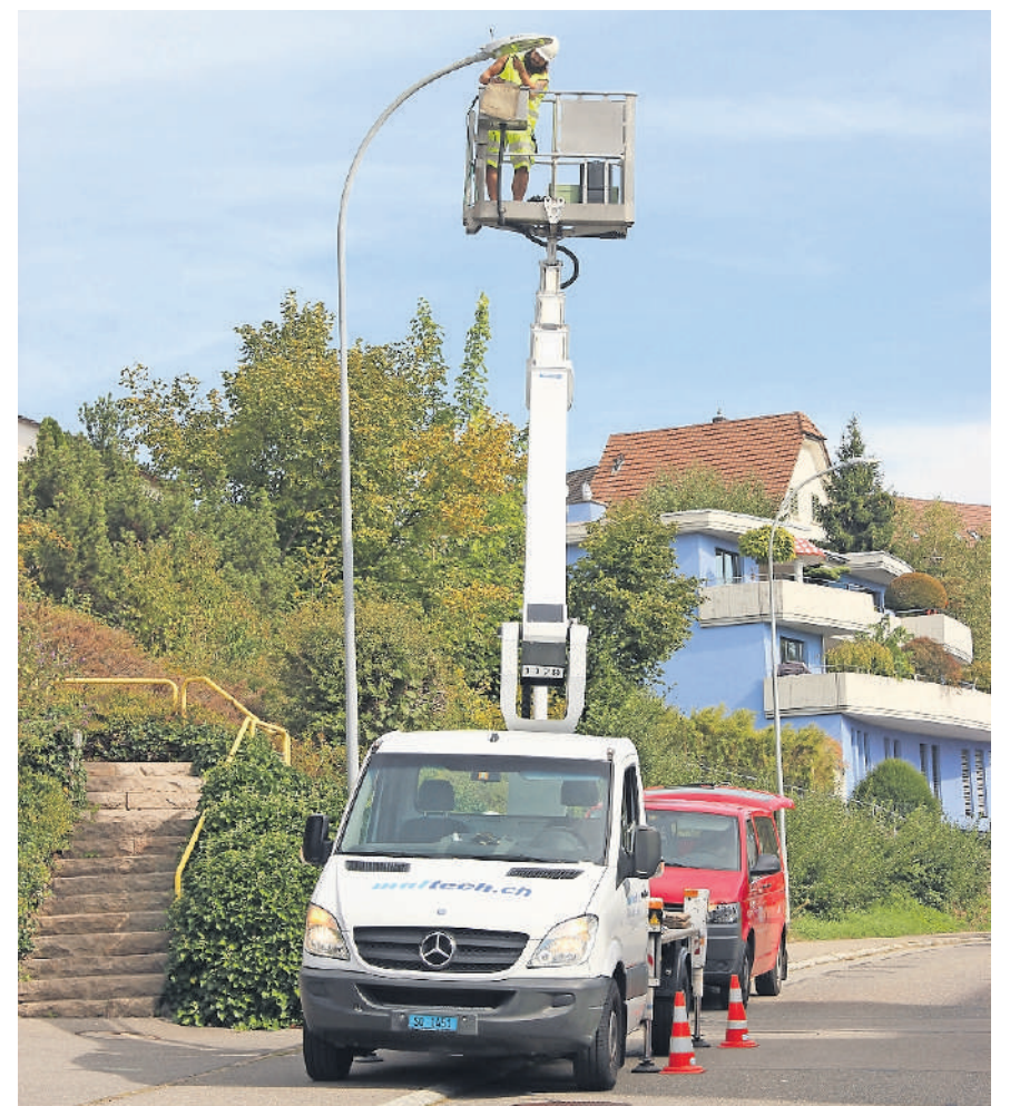
Ein Monteur der Energie Opfikon AG installiert an der Püntenstrasse eine intelligente Strassenleuchte.
